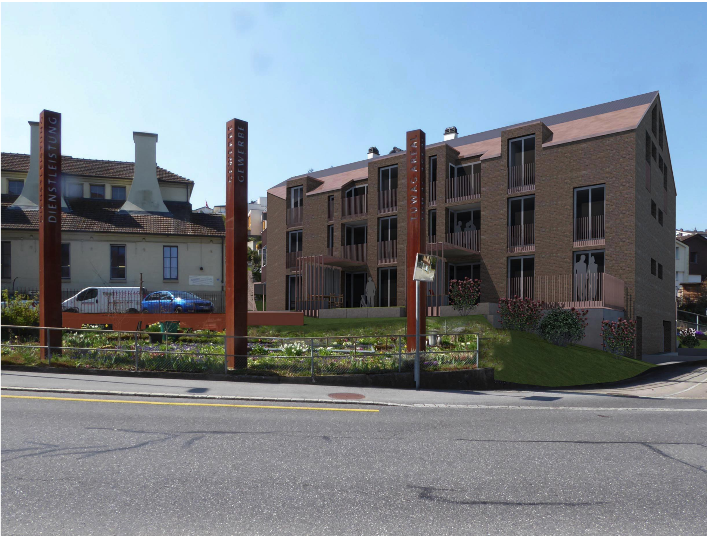
Ansicht von der Einsiedlerstrasse
